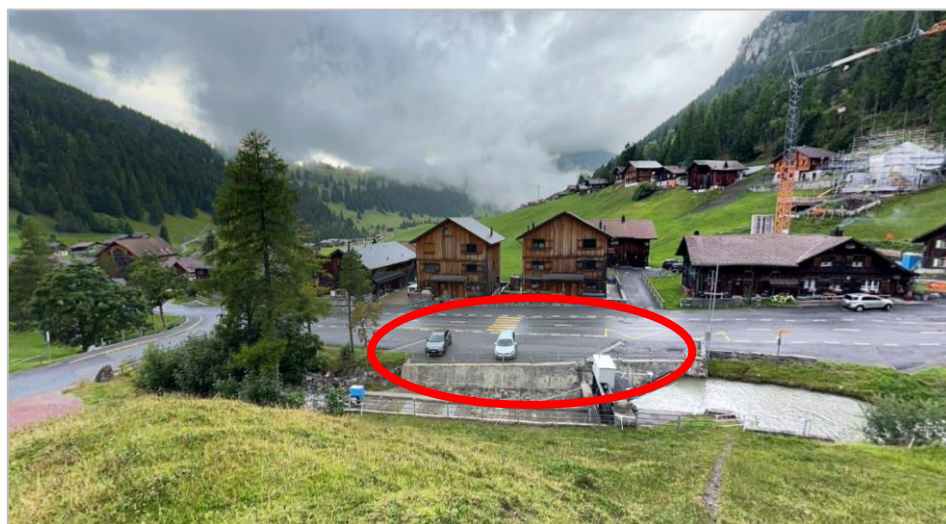
Abb. 7: Situation Fassungsbauwerk Milbunerbach, Standort geplantes Infrastrukturgebäude (rot), Quelle: Google Street View, Fabien Heitz 2022
