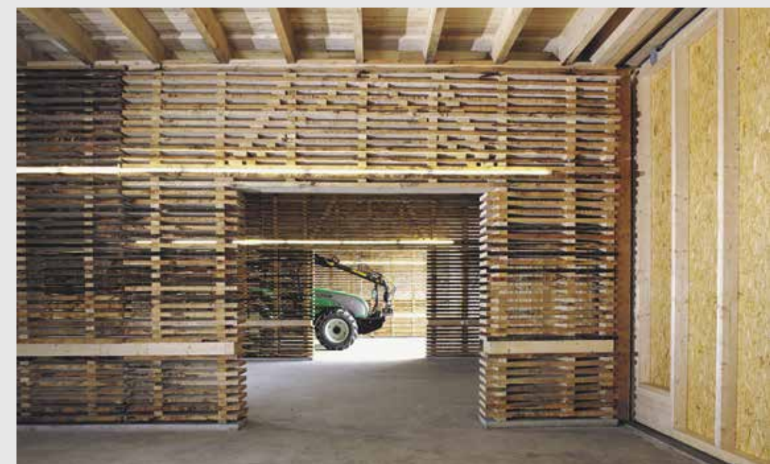
Der Maschinenschopf beim Landesforstbetrieb in Schaan.
