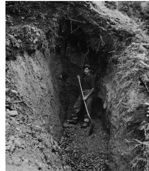
Die Rieteren-Fassungsschlütze im September 1967. Der Name des Arbeiters ist nicht bekannt.
